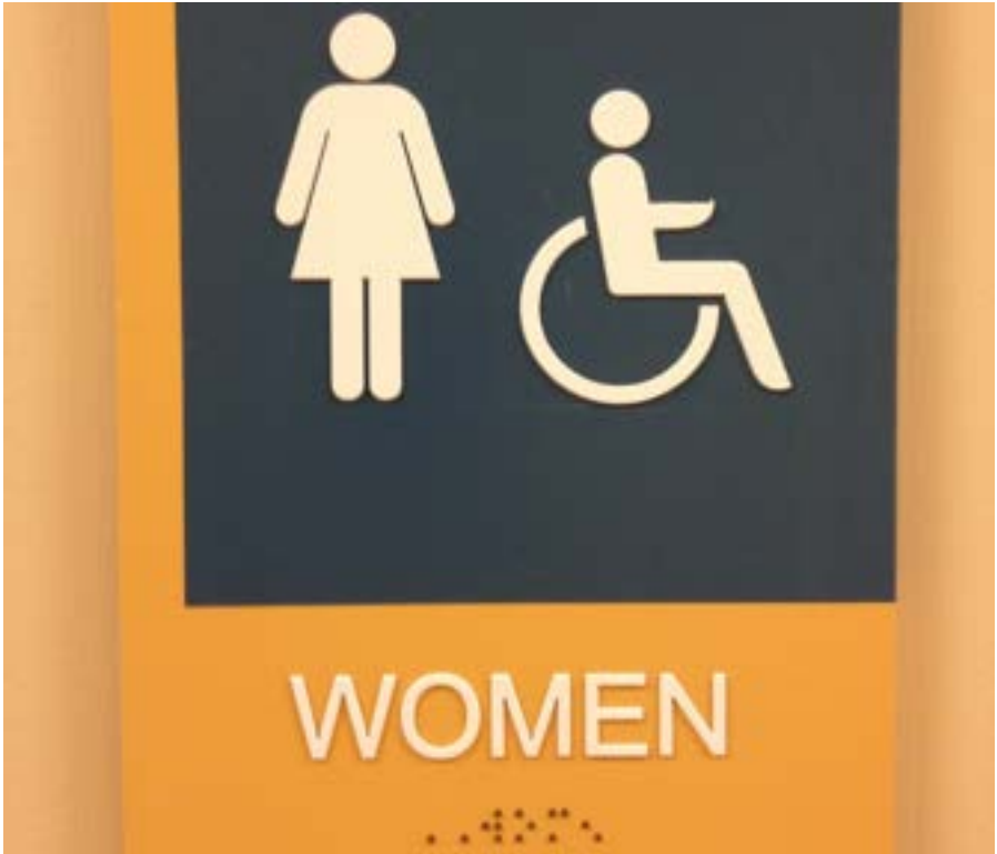
Imágen GE 06 - 1 Señal tacto-visual para sanitarios accesibles
