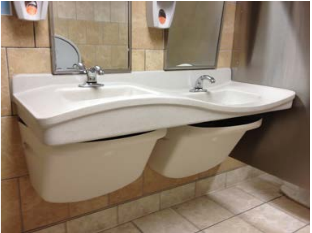
Imágen SS 07 - 1 Lavabos a dos altuas en sanitarios generales
